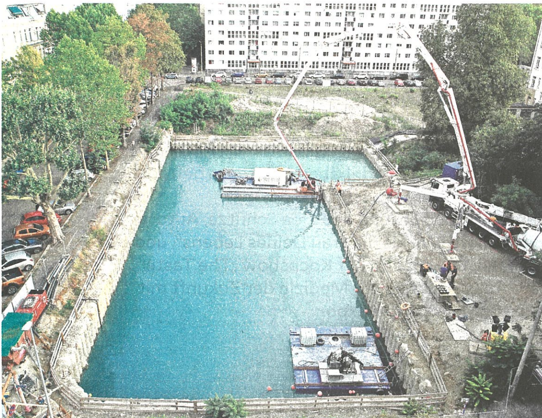
Mit Hilfe von Tauchern wird unter Wasser Beton gegossen.
