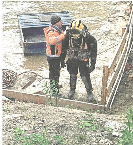
Mit Hilfe von Tauchern wird unter Wasser Beton gegossen.
